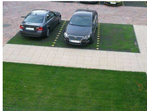
Fot. 2. Przykładowa realizacja parkingu z kratki parkingowej.
